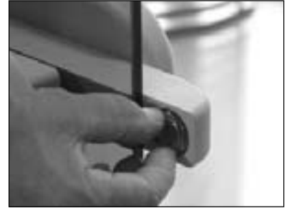
Рисунок 13. Регулировка дверной ручки
